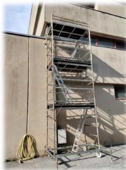
Il ponte su ruote, avente base ampia per resistere ai carichi ed essere sicuro nei confronti del ribaltamento, è stabilizzato durante il lavoro mediante dispositivi appropriati (stabilizzatori, sporgenze, zavorre, sistemi di bloccaggio delle ruote).
