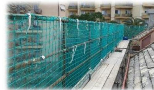
Nello stabilire i requisiti del parapetto devono essere definiti, oltreché la distanza massima fra i correnti, realizzabile anche con l'interposizione di una rete anti-caduta adatta alla posa verticale (cfr. capitolo 3), l'eventuale irrigidimento della struttura ed implementazione degli ancoraggi, anche larghezza e quota dell'impalcato rispetto alla gronda.
