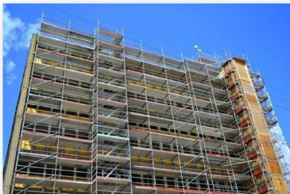
La temporanea rimozione del parapetto interno o di parti di esso rende indispensabile l'adozione di misure di sicurezza equivalenti ed efficaci (art. 111 c. 6 D. Lgs. 81/2008), come l'assicurazione in trattenuta del lavoratore mediante dispositivi di protezione individuali (imbragatura, cordini, moschettoni, ecc.) a parti stabili dell'opera provvisoria ovvero a linea vita.
