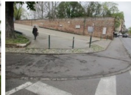
15-punto di raccordo tra il percorso e la sede stradale in corrispondenza di Piazzale Burchiellati
