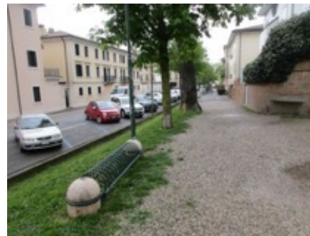
2-Rampa di accesso, si evidenzia pendenza eccessiva e fondo in ghiaio sciolto
