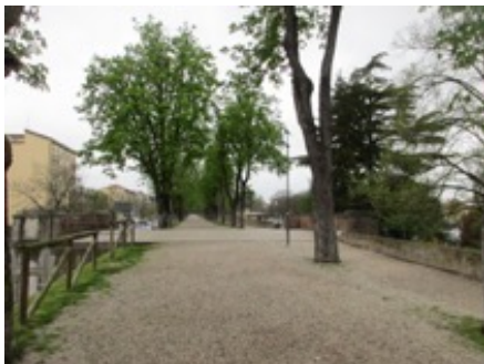
12-il fondo in ghiaino sciolto rende difficoltosa la percorribilità, in particolare della porzione centrale
