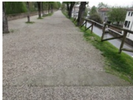
13-presenza di sconessioni
