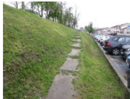
5b-percorso con larghezza non sufficiente < 90cm e con gradini
