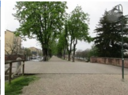
7-ponte su Via Antonio Caccianiga, si evidenzia il cambio di materiale, dal ghiaino sciolto all'asfalto/calcestruzzo
