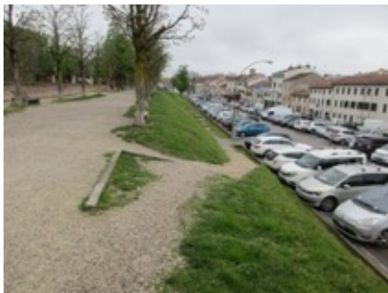
5a-punti di accesso secondari: pendenza eccessiva e salti di quota raccordati con gradini
